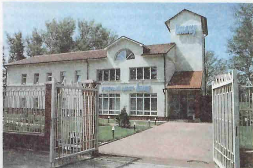
Управленческий корпус «Кнауф Гипс Новомосковск»
