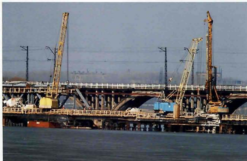
Этапы строительства железнодорожного моста через Любовку
