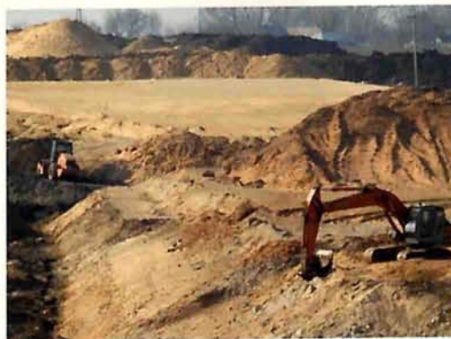
Строится путепровод на пересечении улиц Мира и Куйбышева
