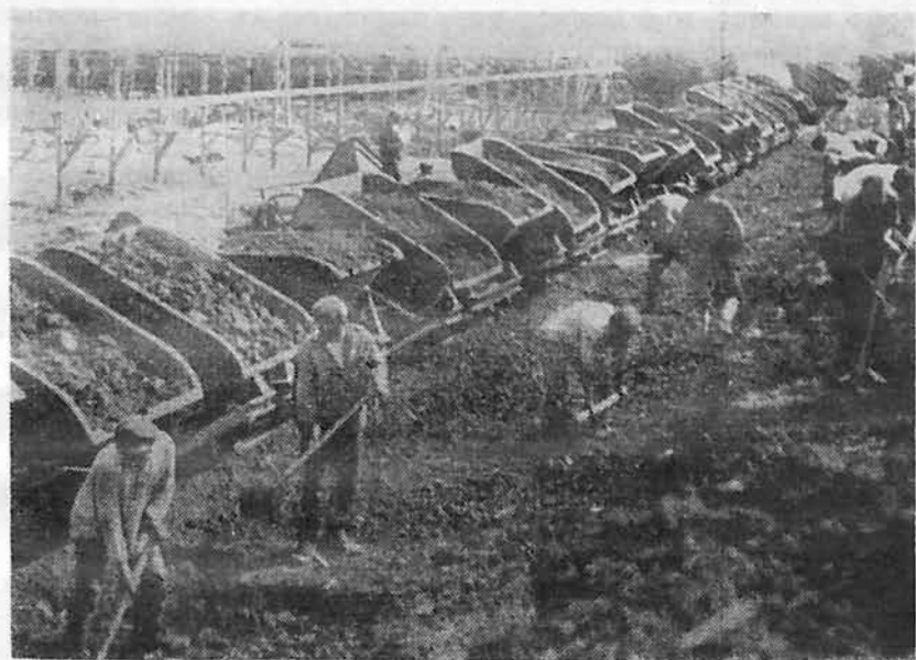
Строительство цехов химкомбината.
