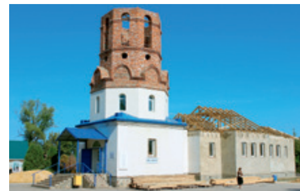
Храм Всех Святых строится. 2012 г.
