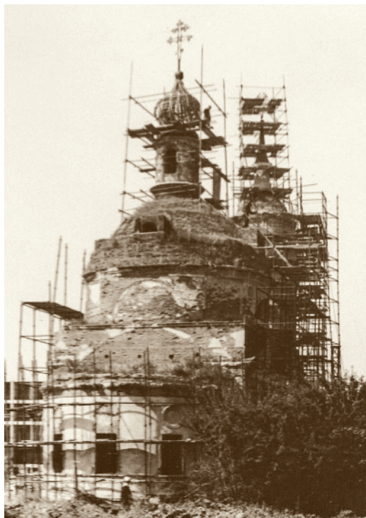
Начало реставрационных работ. Вторая половина 1970-х гг.
