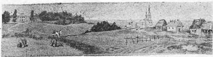
Так выглядело место, где начиналось строительство химического комбината.
