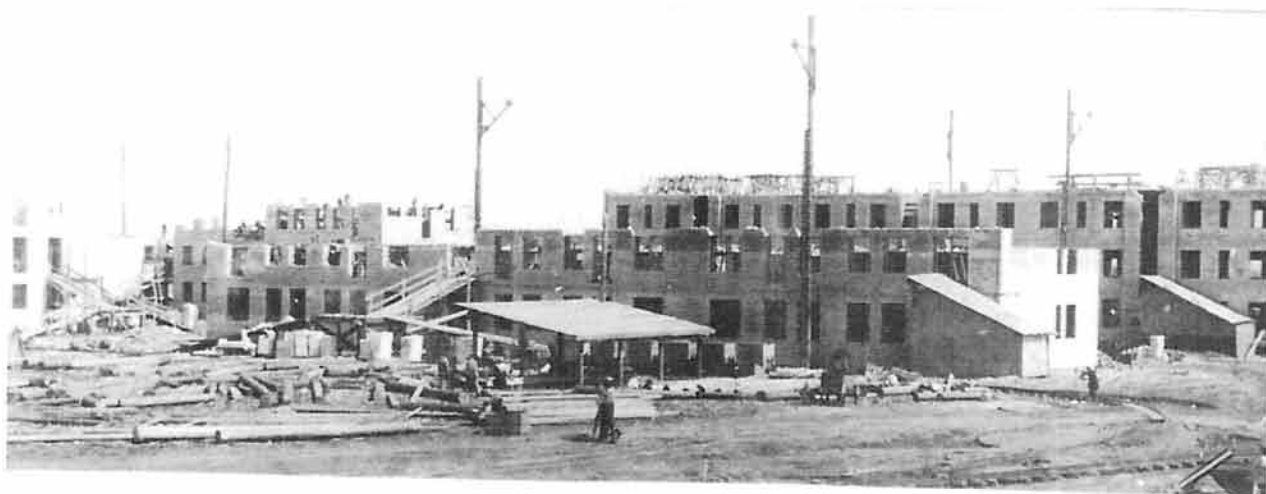
Идет строительство первых каменных 4-этажных домов
