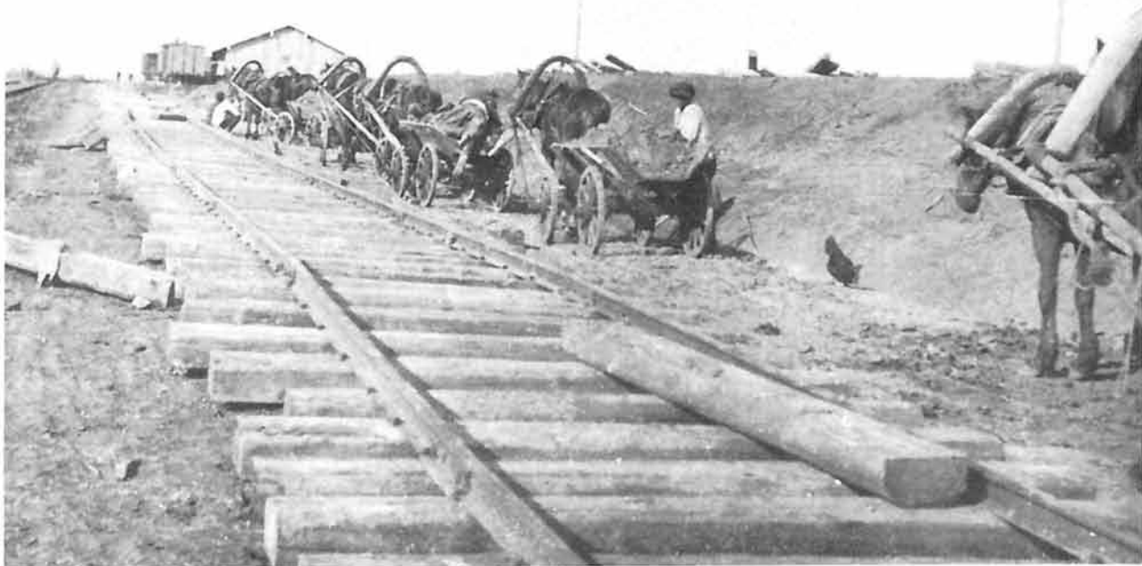
Прокладка железнодорожной ветки от станции Маклец до стройплощадок
