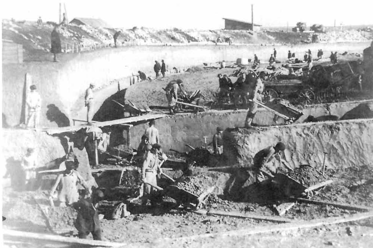
Строится Шатовская плотина
