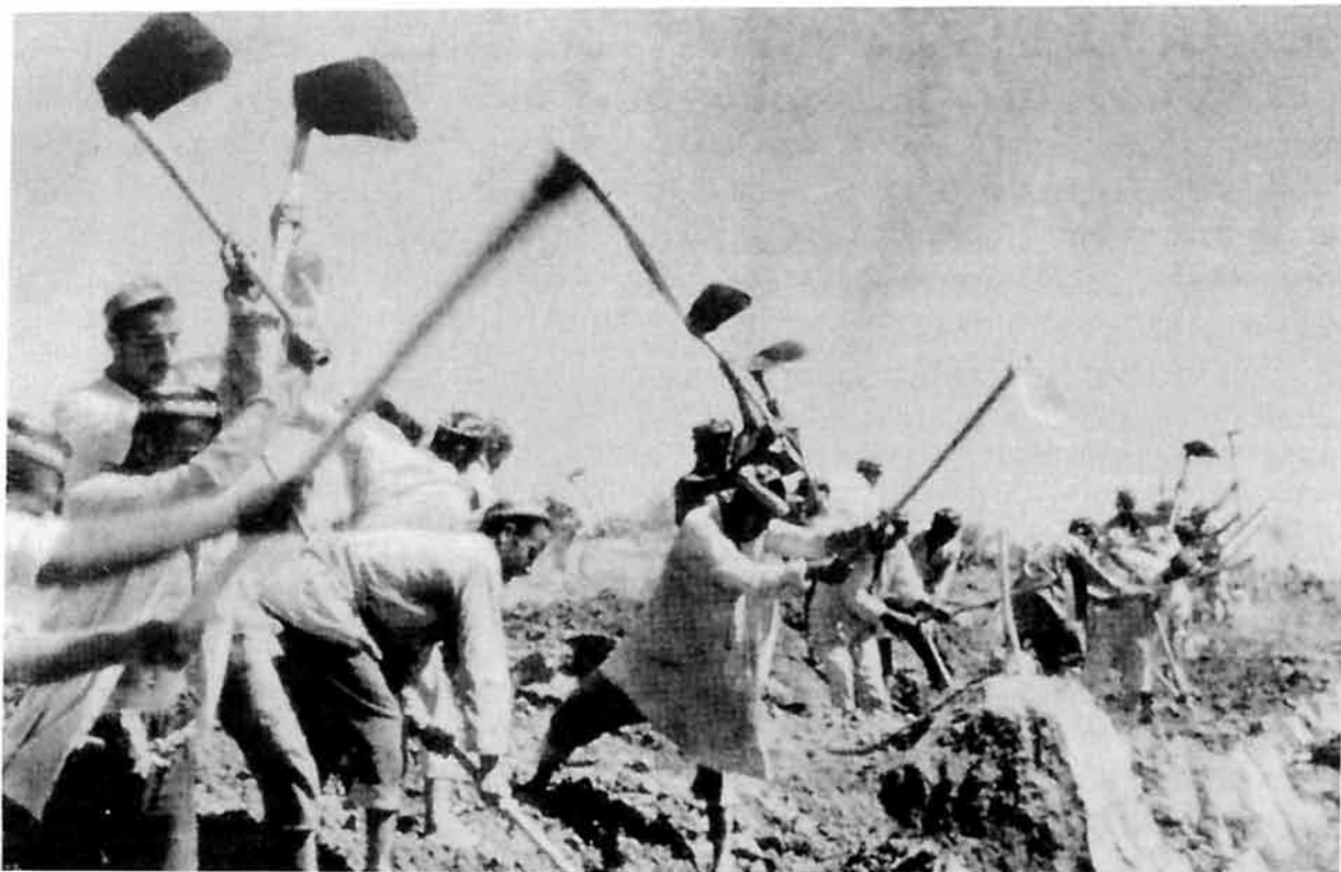
Строительство Ферганского канала. 1939 г.
