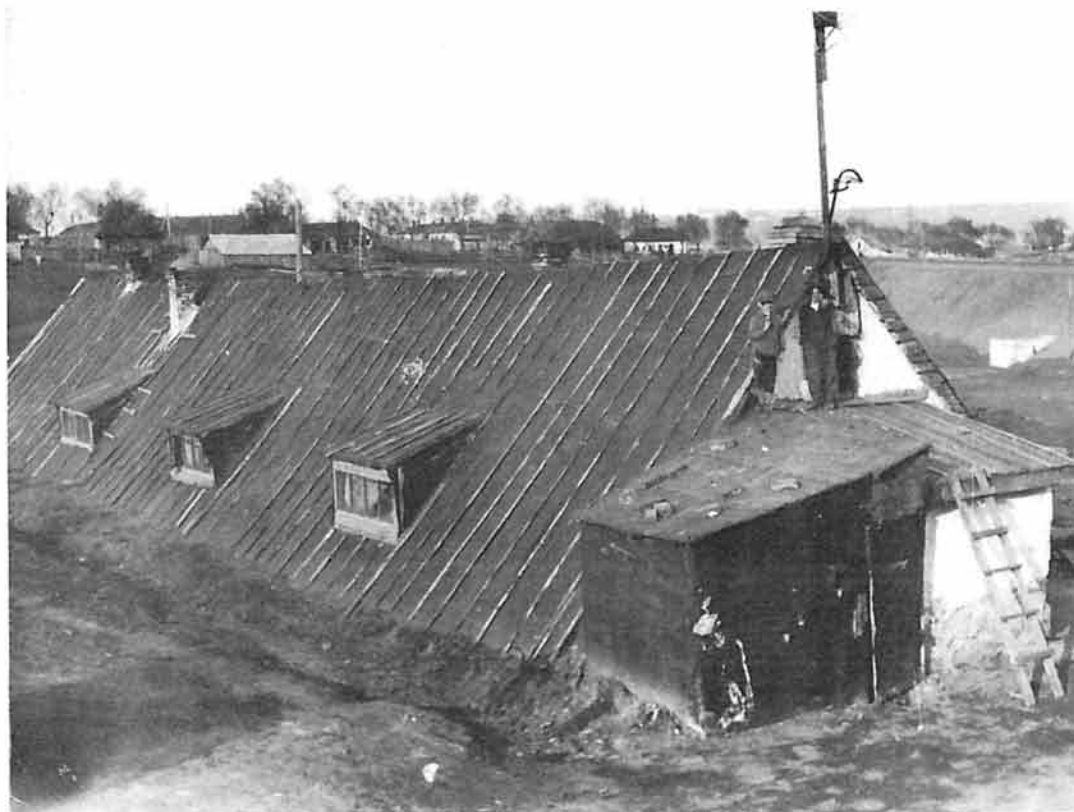
В земляных бараках жили первостроители Новой Москвы
