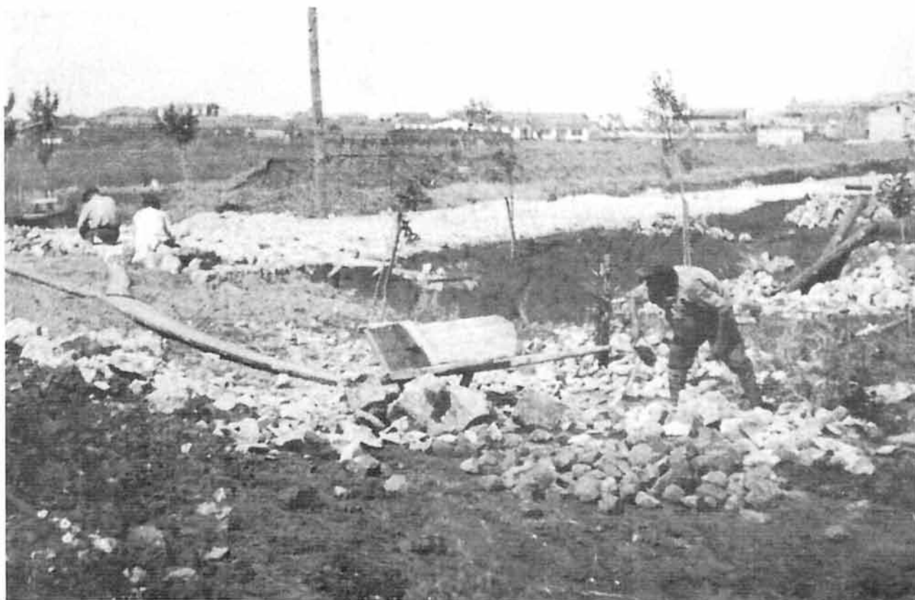
Строительство Комсомольского шоссе
