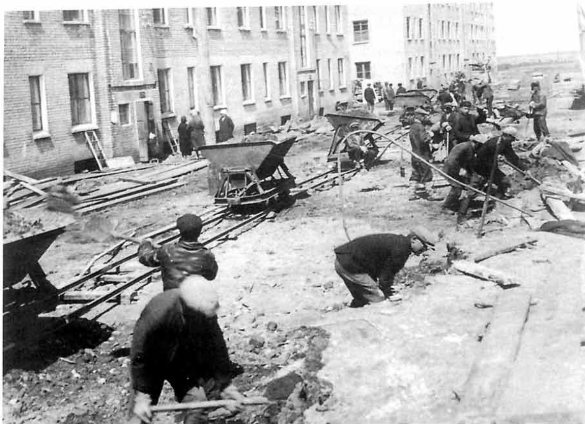
Строительство 42 квартала Соцгорода. 4-этажные каменные дома
