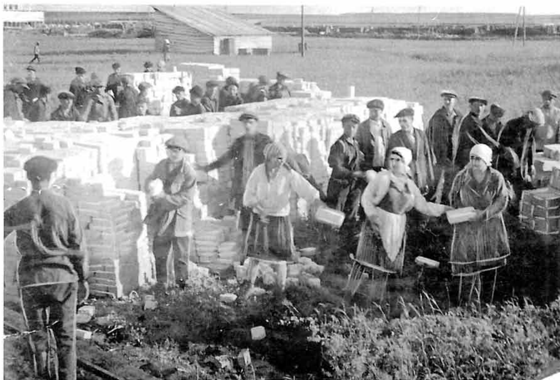
Подготовка к строительству РМЗ химкомбината. 1930 г.
