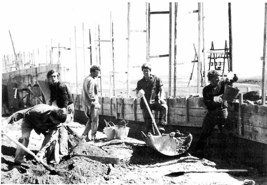
На строительстве коровника в казахской степи
