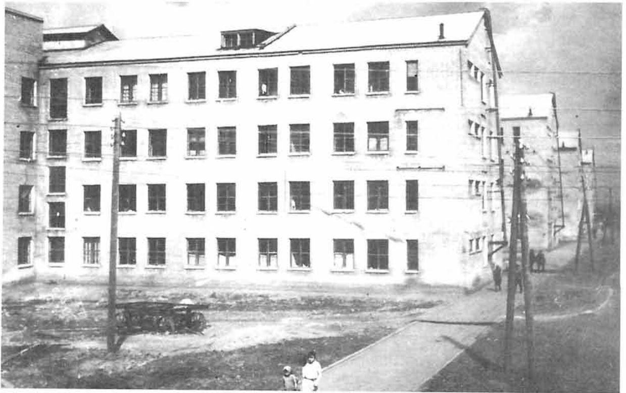
Планировка улиц Сталиногорская отличалась четкостью (ул. Дзержинского)
