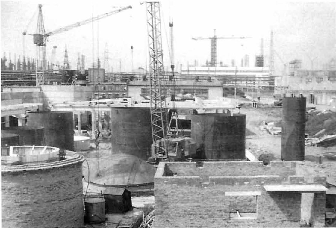
Строительство цехов химкомбината
