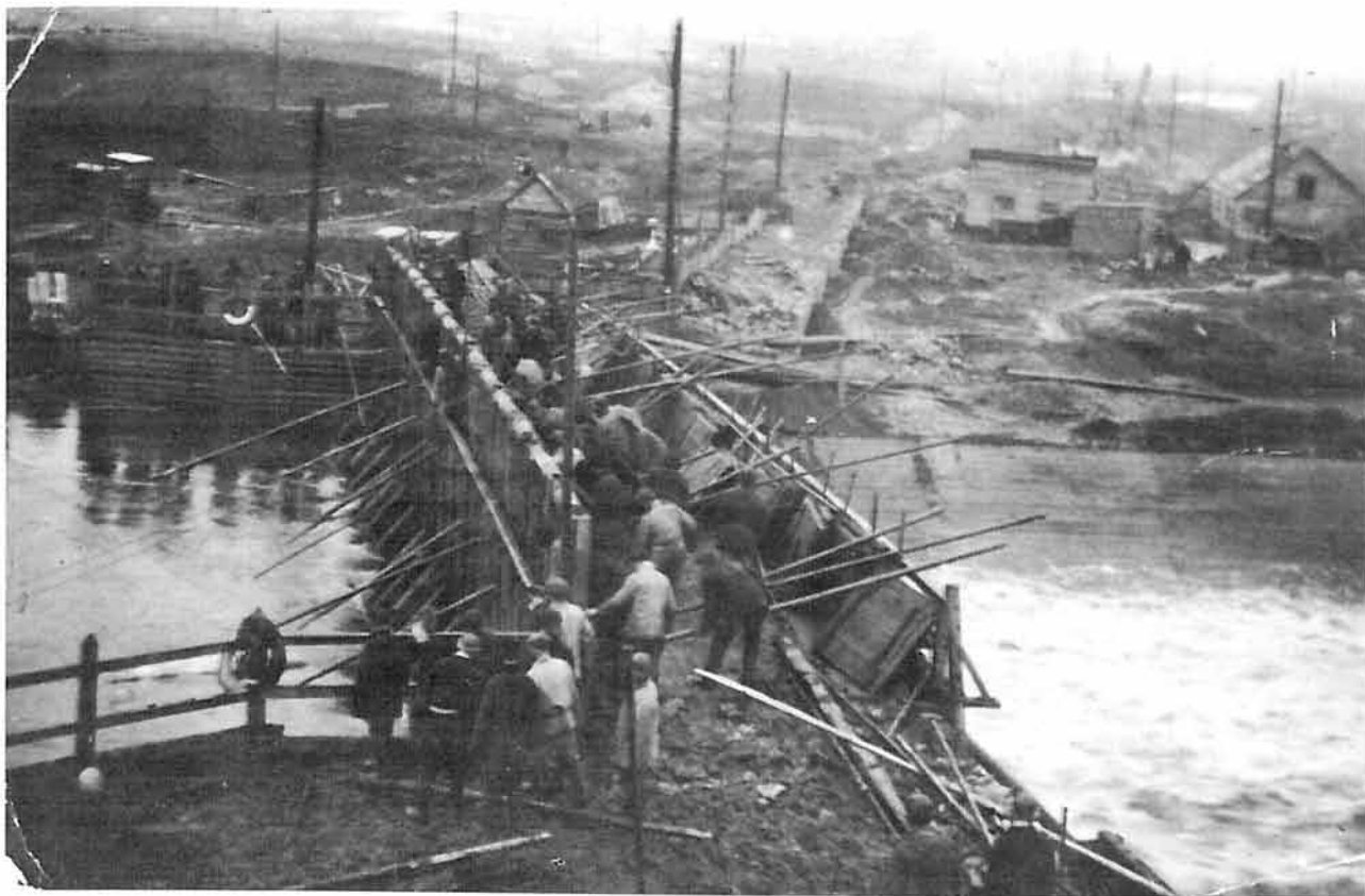
На строительстве Шатовской плотины
