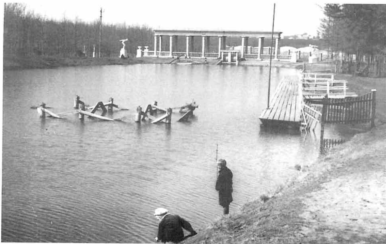
Бассейн по окончании строительства
