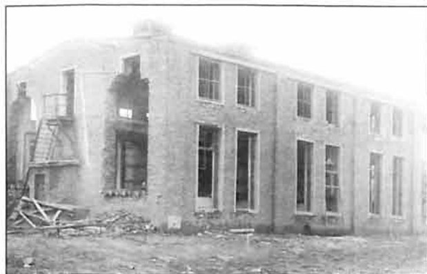
Повреждения в промежуточном цехе №12.
