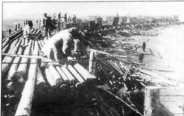
Эшелон леса для стройки.
