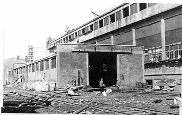
Восстановление южного фасада.
