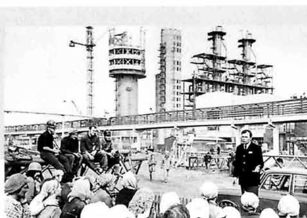
Звучат стихи на строительной площадке.
