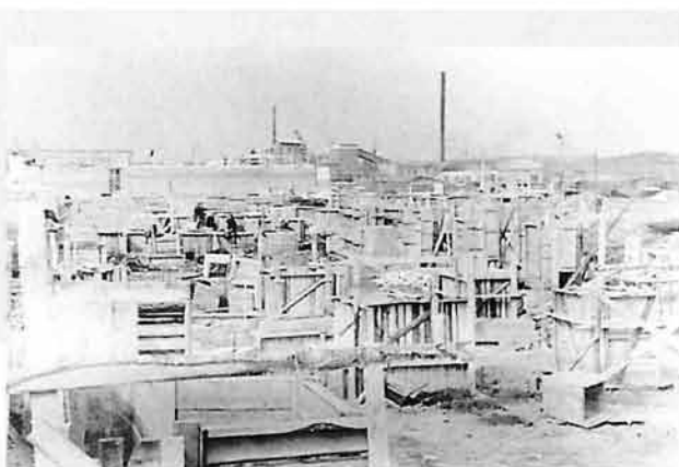
Заливка бетона в опалубку.
