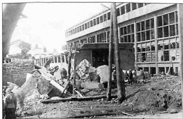
На уборке разрушенных зданий.
