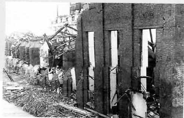
Разрушенный цех конверсии.
