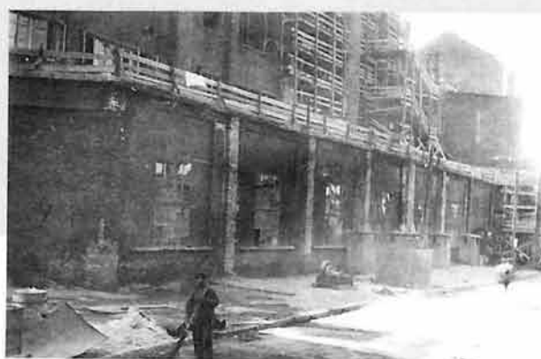
Восстановление северного фасада.
