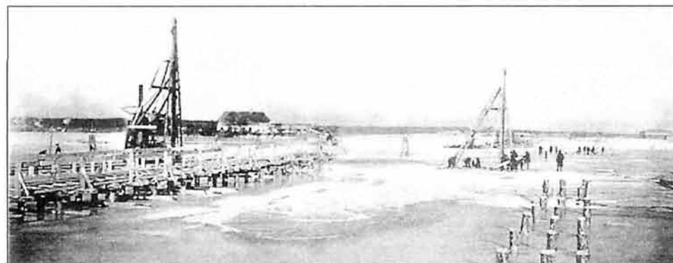
Первая зима на плотине.
