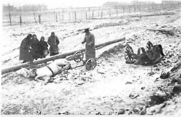
Дорога между хлебозаводом и сквером в Северном городе (1931 г.)
