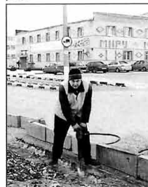
Ремонт дорог и тротуаров.
