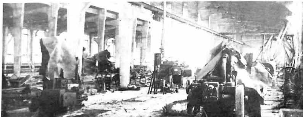
Установка оборудования в механическом цехе РМЗ. (1932 г.)
