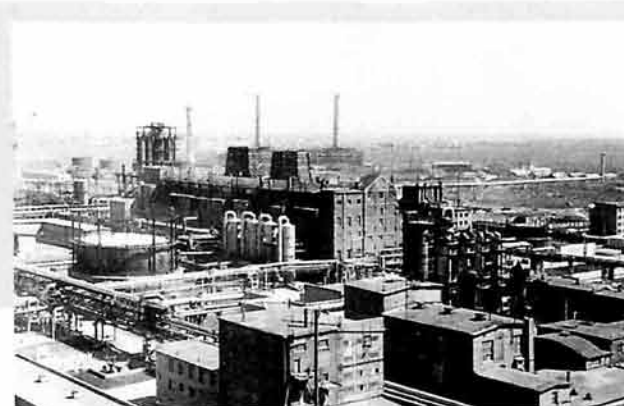
Вид на газовый цех.
