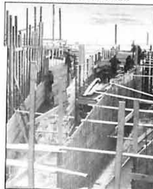
Строительство Шатовской плотины.
