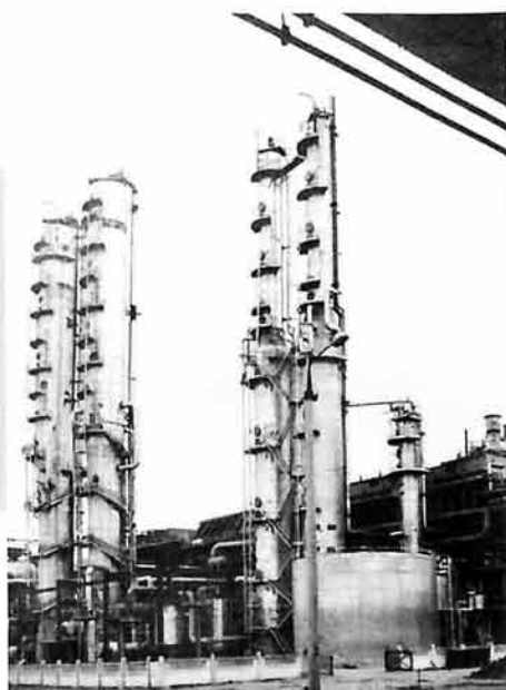
Колонны синтеза цеха аммиака-3.
