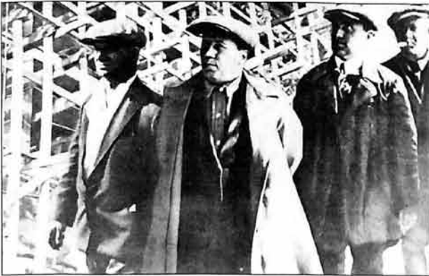
Начальник строительства Петр Арутюнянц на обходе участков.
