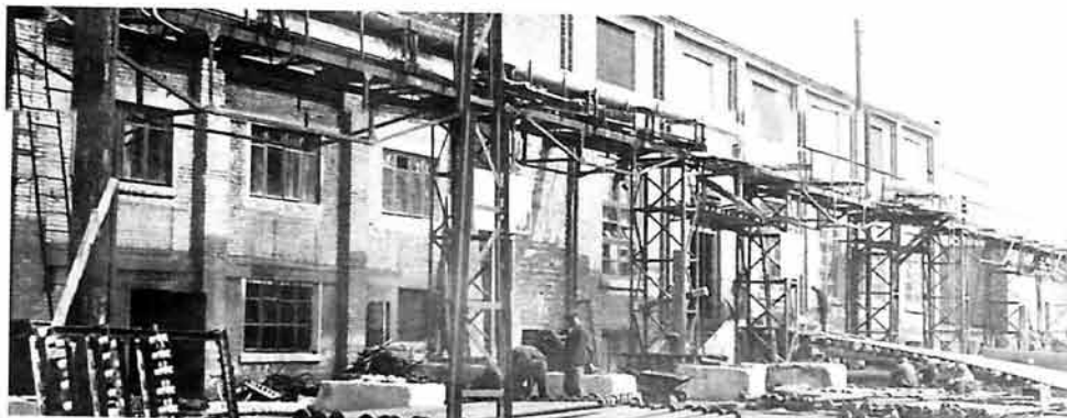
Восстановление. Южный фасад.
