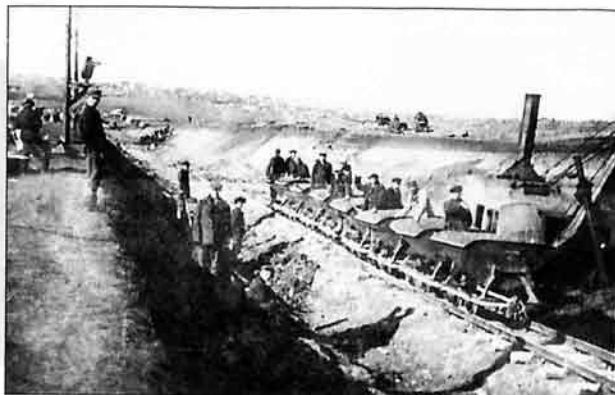
Механизованная подача гравия.
