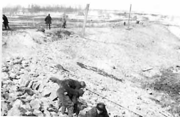
Работа по укреплению плотины.
