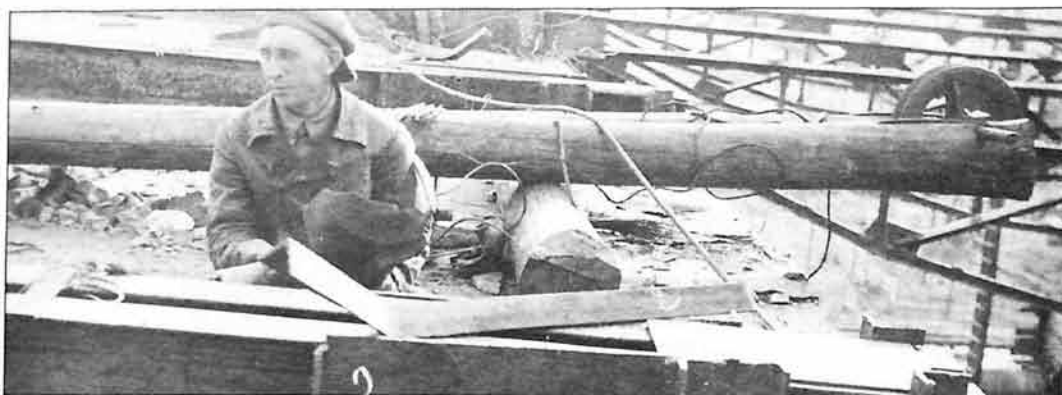
Ремонт ферм и прогонов.
