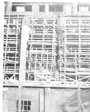
Восстановление северной стены.
