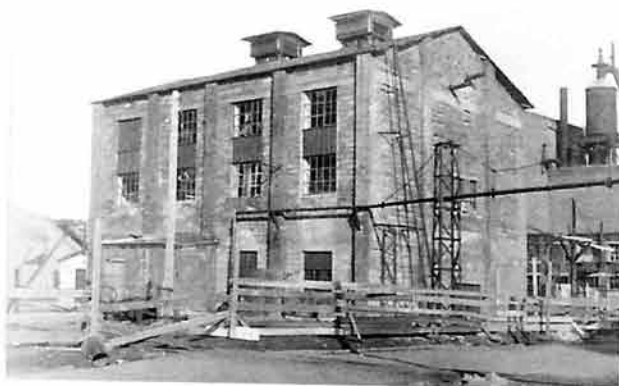
Вид на восстановленный цех №19.
