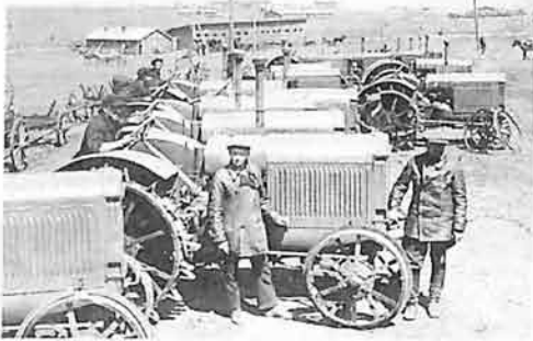
Первая техника, поступившая на строительство.
