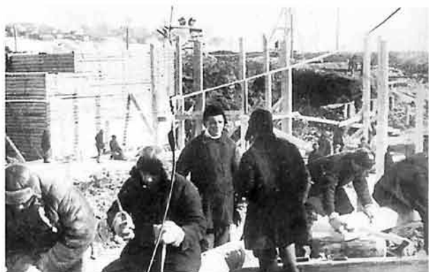
Плотники на строительстве.
