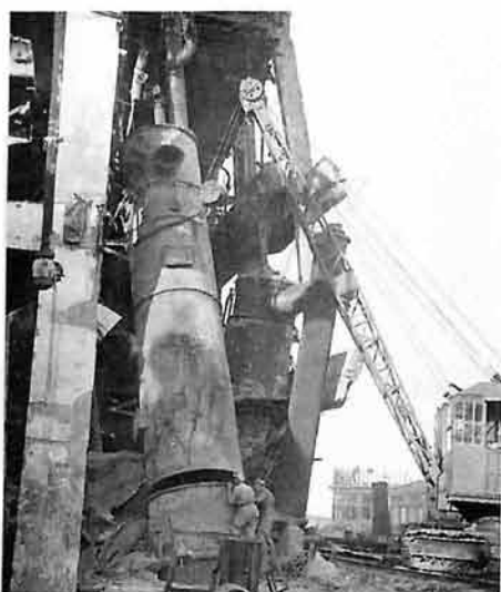
Демонтаж разрушенного оборудования.
