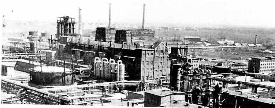
Вид на газовый цех.
