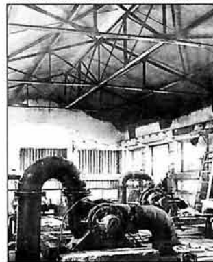
Насосная станция №3 после восстановления.
