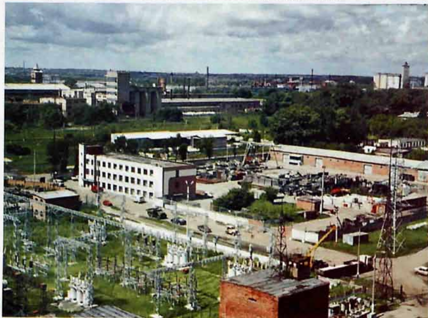
Электрические сети ОАО «Тулэнерго»
