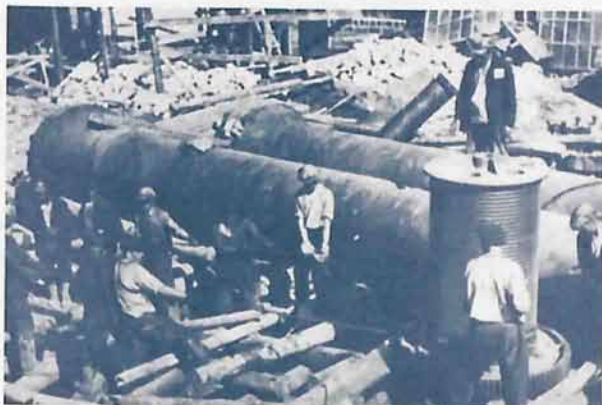
1942 год Восстановление химкомбината Газовый цех Разгрузка оборудования
