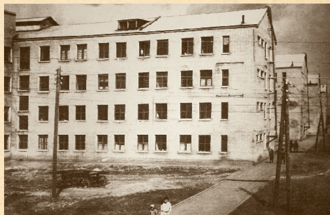
Новые кирпичные дома (1930 г.)
