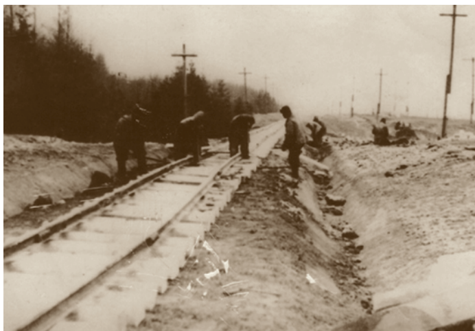
Укладка пути. 1953 г.
