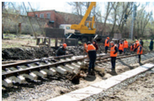
Укладка нового железобетонного пути
