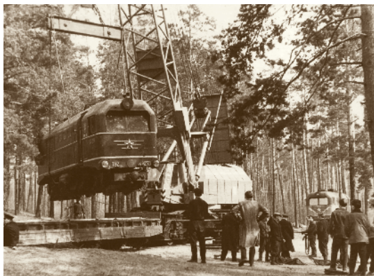
Транспортировка тепловоза ТУ2. 1970 г.
