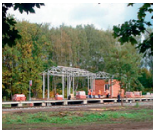
Строительство платформы «Исток Дона»
