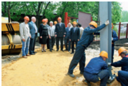
Установка первой опоры учебного корпуса. 2010 г.
