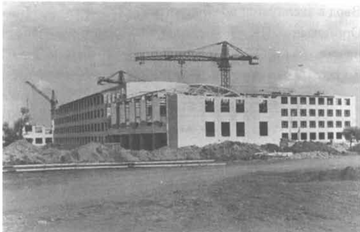
Идет строительство учебного корпуса №4.
