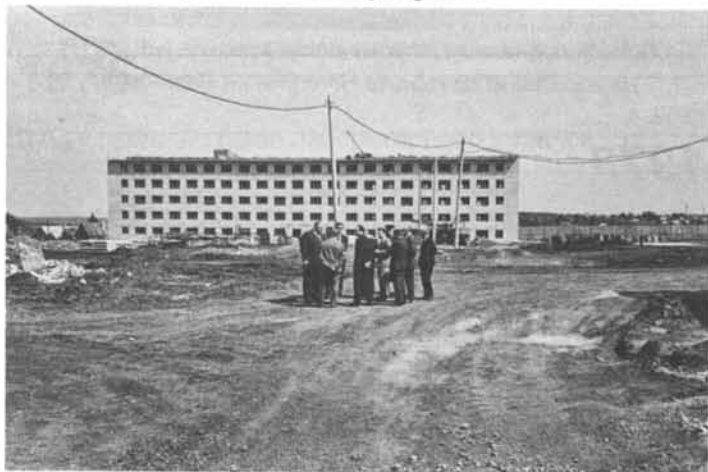
Заканчивается строительство общежития № 3
